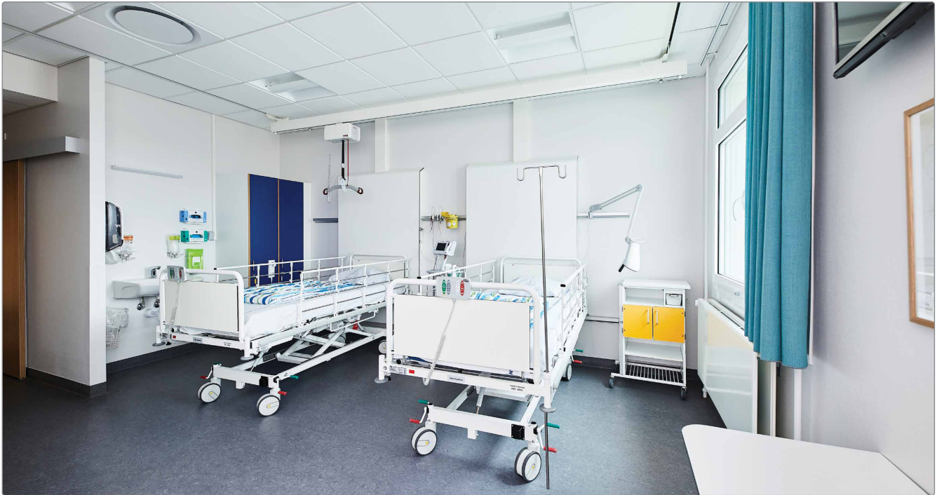
Rumdækkende skinnesystem på 2-sengs stue.
